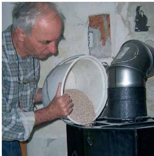
Füllung der Thermobox mit Magnetherm-Granulat
