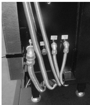
Beispielhafte Rohrverlegung mit flexiblen Schläuchen
